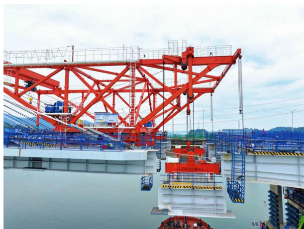
新建金马大桥合龙段吊装
