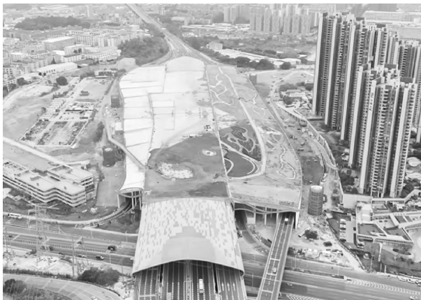
图 8 新塘立交改造建设中实景
