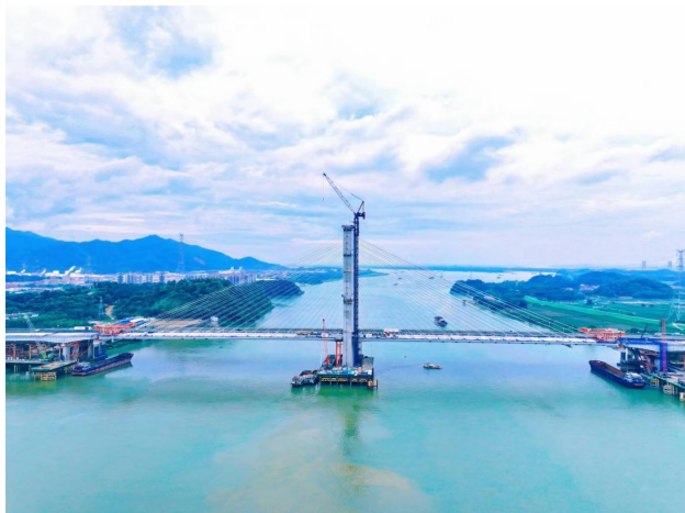
广肇高速改扩建项目新建金马大桥顺利合龙
