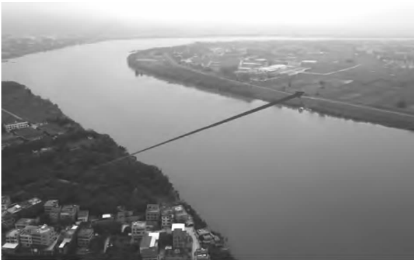
图 2 东江特大桥桥址
