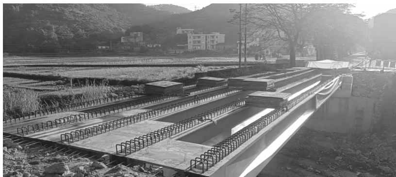
图 1 预应力无腹筋 UHPC 预制梁桥
