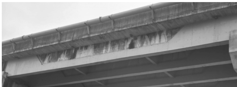
图 2 UHPC 薄层加固 T 梁桥
