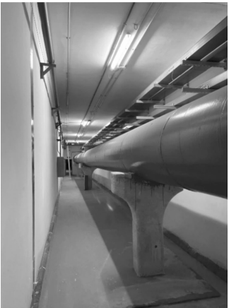
图 5 重力流污水管道支墩实拍图
