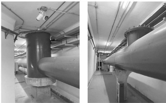
图 12 直通检查井和清扫口相结合的现场图片
