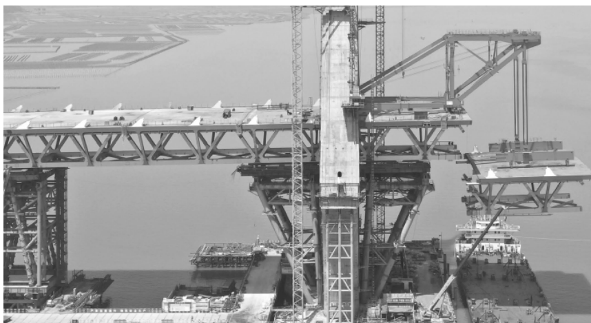
图 10 架桥吊机整节段吊装拼装
