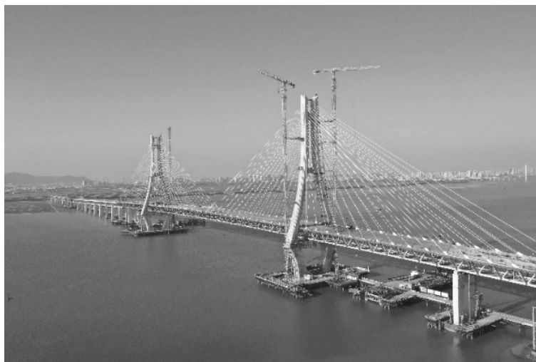
图 11 牛田洋大桥主桥合龙后实景
