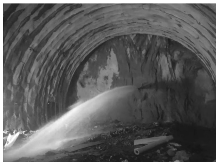
图 2 隧道掌子面超前地质钻孔探水
