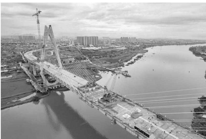
京灶大桥顺利合龙
