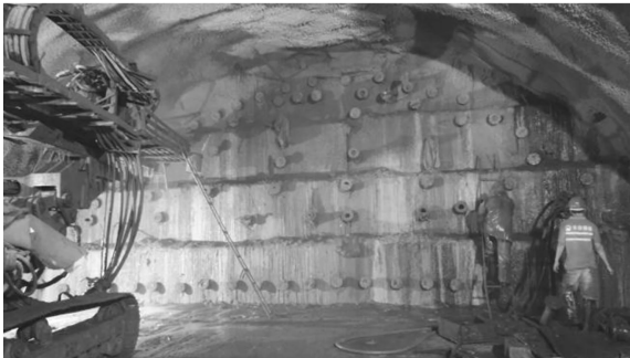
图 16 帷幕注浆现场实施图
