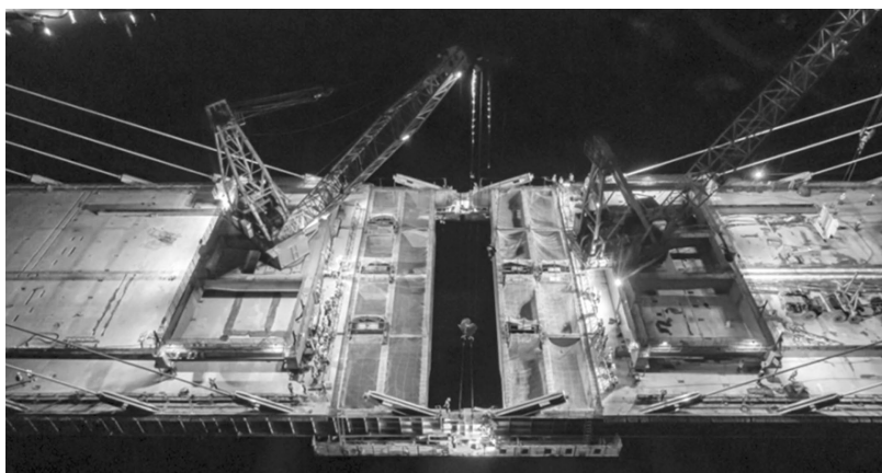
京灶大桥合龙段吊装
